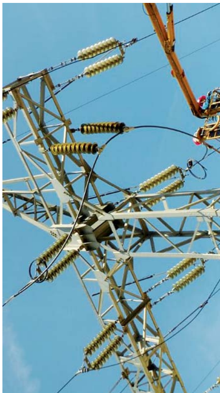
Монтаж изолирующих шлейфов (провод СИП 7 и специальная арматура производства ООО «МЗВА»)
