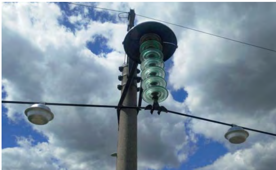
Птицезащитный экран ЗП-ЭС1 и широкополосные гасители вибрации
